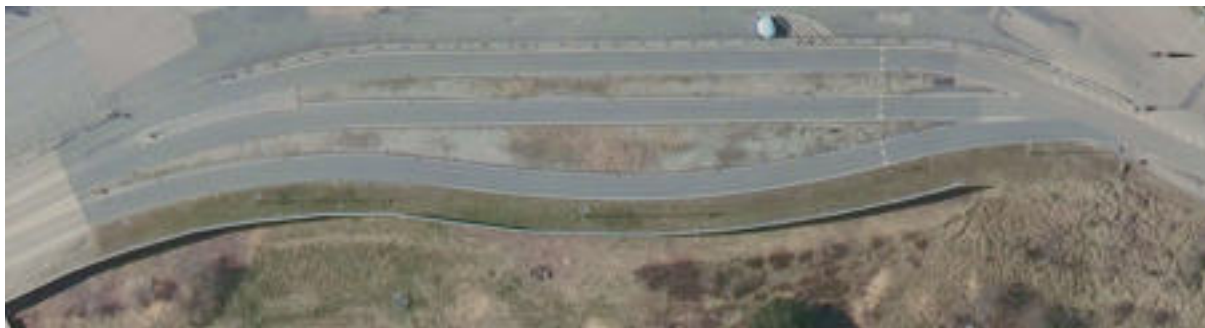
Figur 2: Eksisterende forhold ved udkørsel fra havneområdet.
